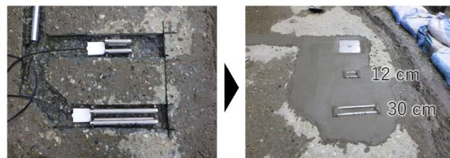
図-1 足洗谷観測水路の水路床に TDR センサーを設置した様子
