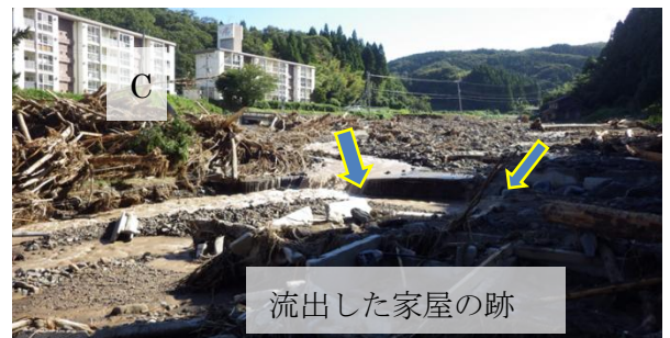
図-7 塚田川下流C地点における流木による橋梁の閉塞と土砂・洪水氾濫
