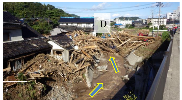
図-8 塚田川下流D地点における流木による橋梁の閉塞と家屋の被害
