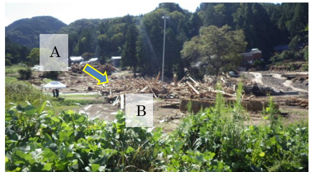
図-6 塚田川下流A地点、B地点における流木による橋梁の閉塞と土砂・洪水氾濫
