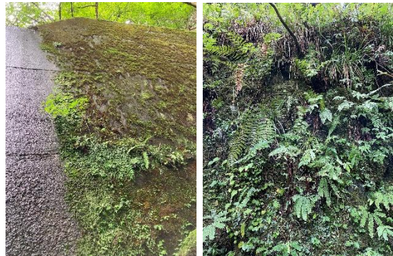
図 1 堰堤壁面 (左: コンクリート, 右: 石積み)
