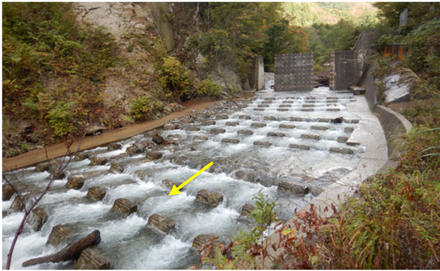
図1 全断面式魚道による落差対策の工夫
