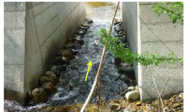
図6 スリット両側に礫を配置した事例
