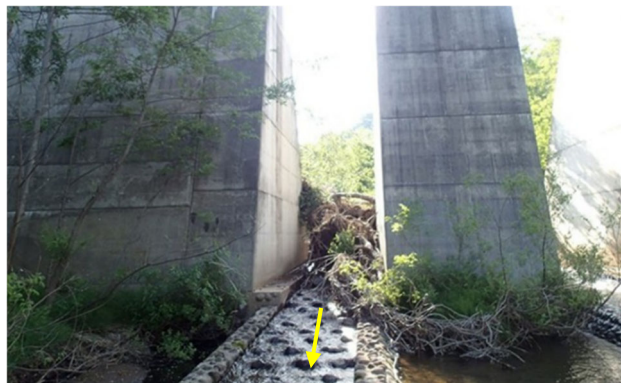
図5 スリット内に礫を配置した事例
