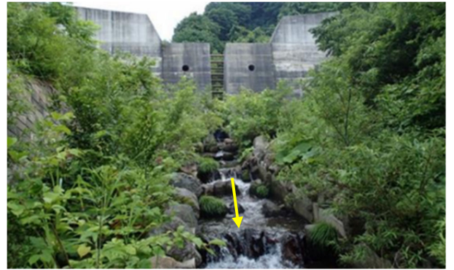
図2 魚道による落差対策の工夫
