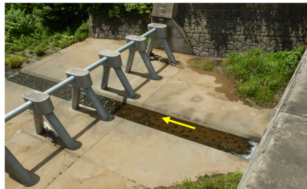
図7 溝を設置して水深を確保した事例
