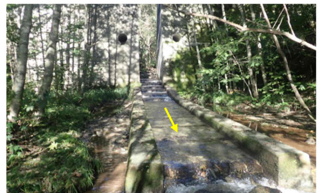
図8 壁を立てて水深を確保した事例
