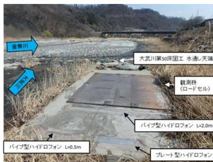
写真-1 大武川第50床固工右岸流砂量観測機器設置状況
