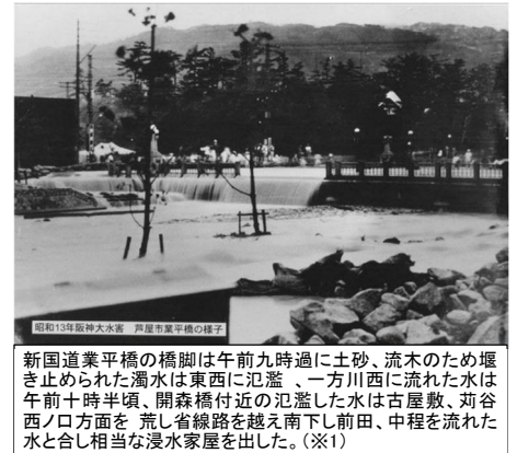
図1 流木災害に関する記録の一例 （S13阪神大水害 芦屋川 業平橋（国道2号））
