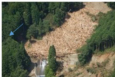
写真-1 九州北部豪雨で大量の流木を捕捉した 須川第1砂防堰堤(国土交通省 HP より)
