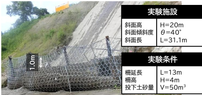
図－4.1 実験施設状況および実験条件
