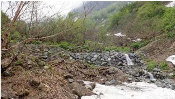
写真1 現存する施設に見られる主要な工法 左) 堰堤: 石積堰堤工 (西ノ谷) 中央) 水路: 石貼水路工 (西ノ谷) 右) 石垣: 山腹工 (石積土留工) (金山谷)
