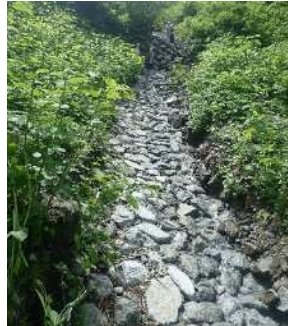
写真1 現存する施設に見られる主要な工法 左) 堰堤: 石積堰堤工 (西ノ谷) 中央) 水路: 石貼水路工 (西ノ谷) 右) 石垣: 山腹工 (石積土留工) (金山谷)
