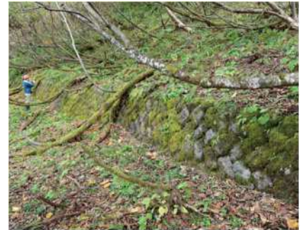
写真1 現存する施設に見られる主要な工法 左) 堰堤: 石積堰堤工 (西ノ谷) 中央) 水路: 石貼水路工 (西ノ谷) 右) 石垣: 山腹工 (石積土留工) (金山谷)
