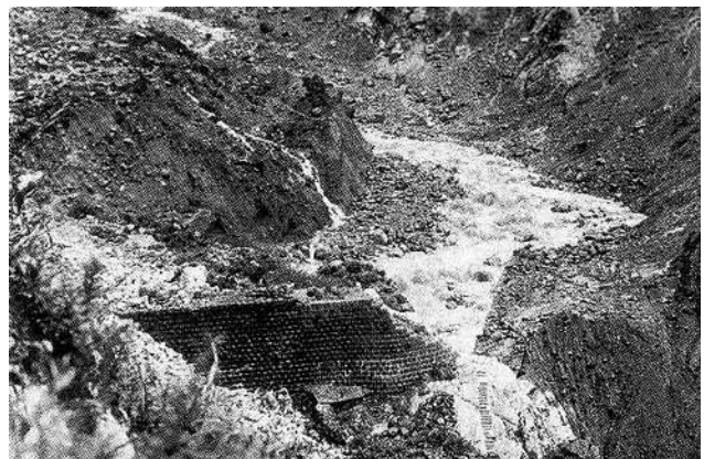
写真2 土石流によって破壊された湯川第1号砂防堰堤
