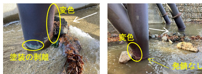
図 1 片倉第1 砂防堰堤鋼製スリット部状況 (左：スリット部右岸，右：スリット部中央)
