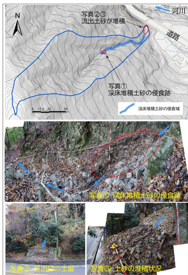
図-3 2024年11月2日の土砂流出状況
