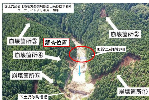
図1. 下土沢砂防堰堤 被災当時の様子
