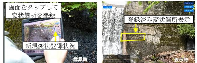
図-8 変状箇所の登録機能による変状位置の描画状況
