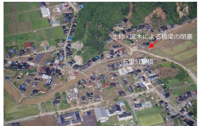
図 7 五里分新橋下流付近における浸水被害状況
