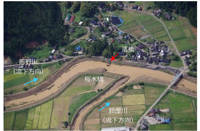
図 6 町野川・鈴屋川合流点付近の被害状況
