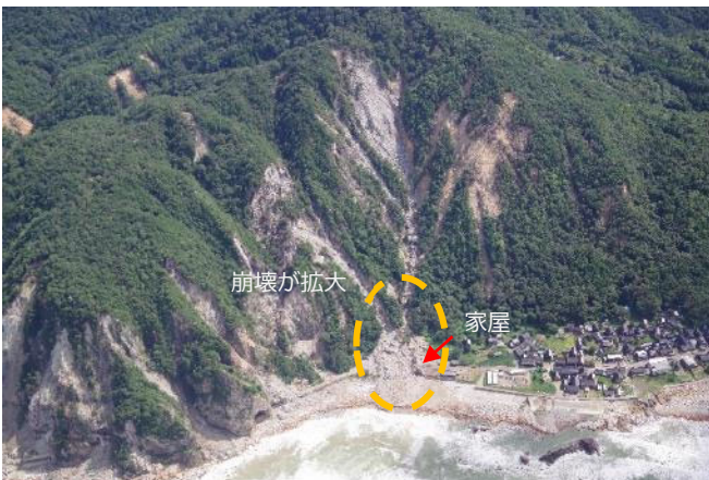
図 5 曾々木海岸付近における斜面崩壊(豪雨直後)
