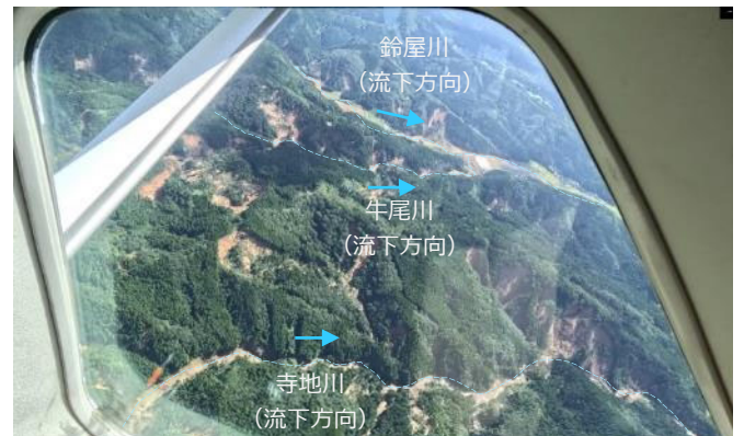
図 8 鈴屋川・寺地川における斜面崩壊の様子(遠景)
