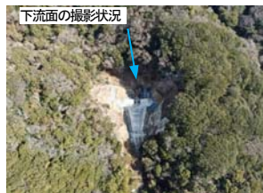
図-5 定点撮影写真(下流面の撮影状況)
