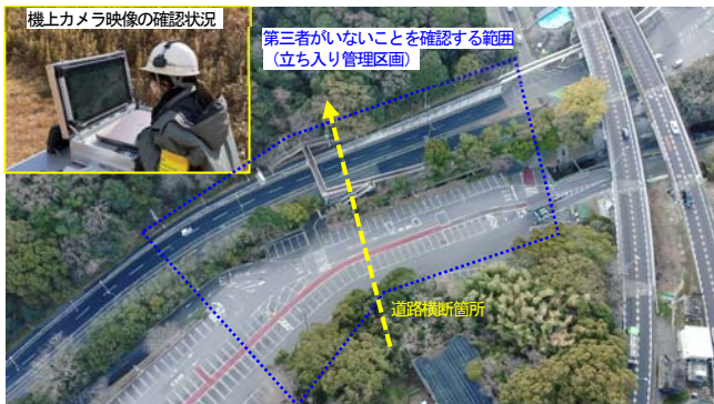
図-4 道路横断時の機上カメラ映像確認状況
