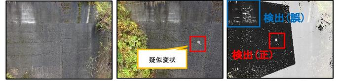
前回点検 今回点検 (画像加工) 差分解析結果
