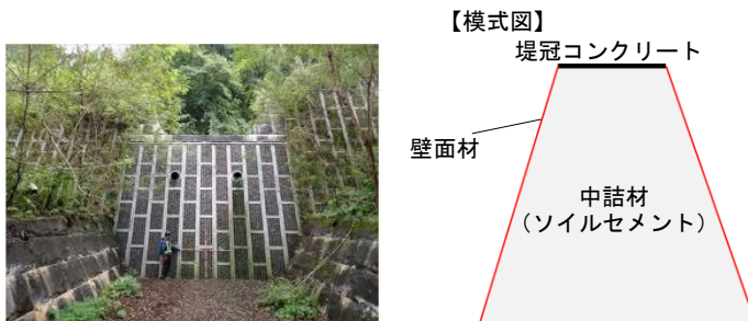
図 - 1 DW 型砂防堰堤の例
