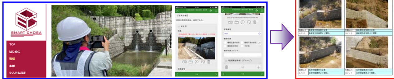
図-2 「スマート調査」を用いた点検及び結果とりまとめの状況
