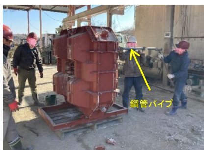
図3 ボイド管の取り外し状況
