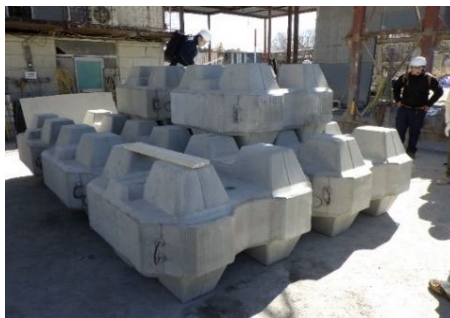
図7 2段積み据え付け完了
