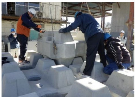
図6 ブロックの据え付け状況
