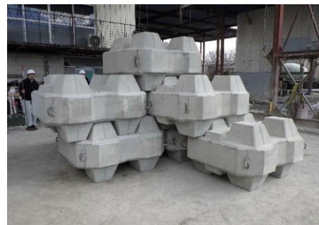
図8 3段積み据え付け完了
