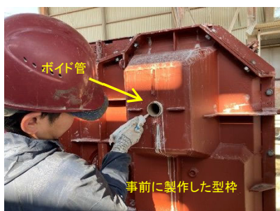
図2 型枠の製作とボイド管
