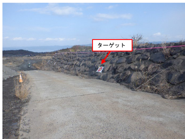
図-2 ターゲット設置状況
