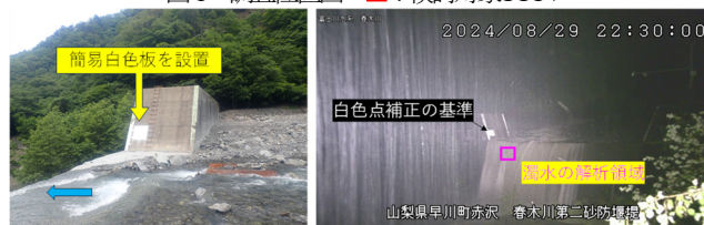
図-2 春木川第二砂防堰堤の簡易白色板設置状況
