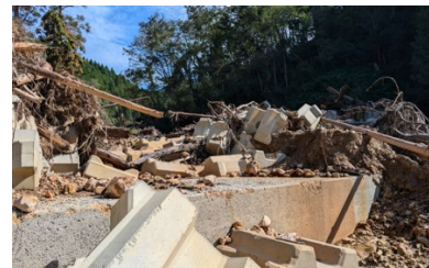
写真-1 ブロック積堰堤（2024/10/18 撮影）
