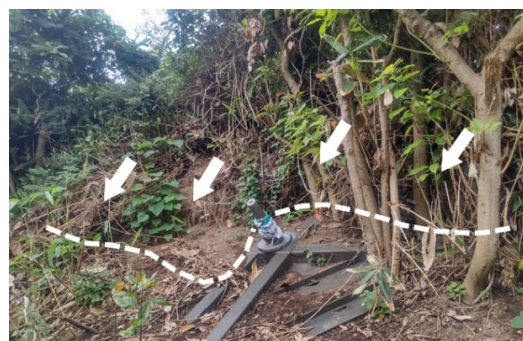
写真1 跳ね上げすべりによる土塊の押出し
