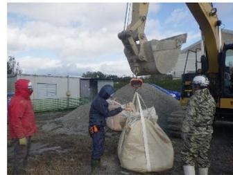
図-2 母材投入量の事前計測
