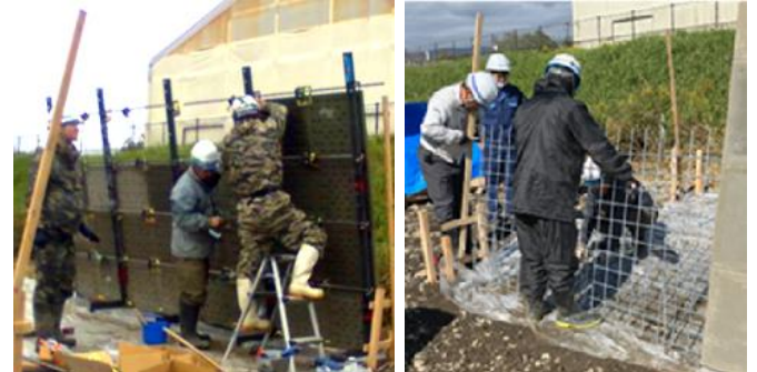
(a) 残存型枠
