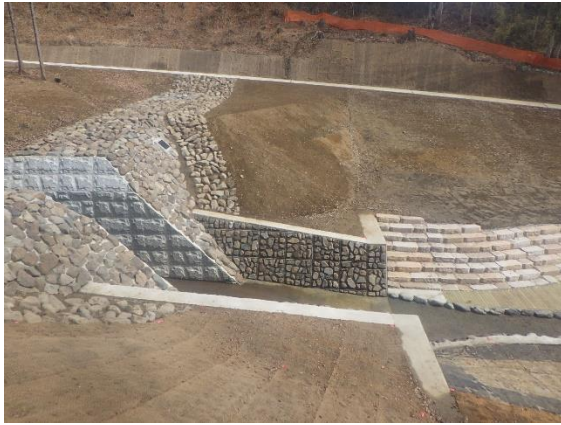
図3 構造物に合わせた修景工法
