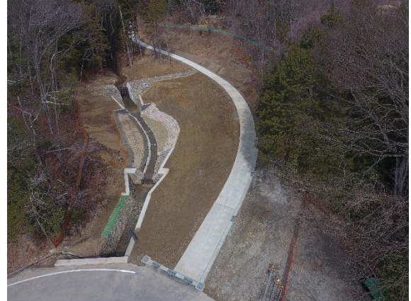
図5 新設砂防堰堤(左奥)と親水エリア(R7.3 撮影)
