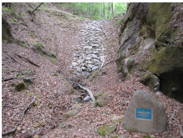
図1 4号石積堰堤（最上流）
