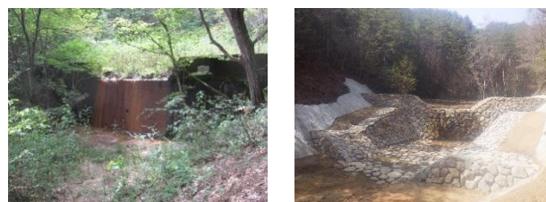
図2 改築前（左）改築後（右）の谷止工
