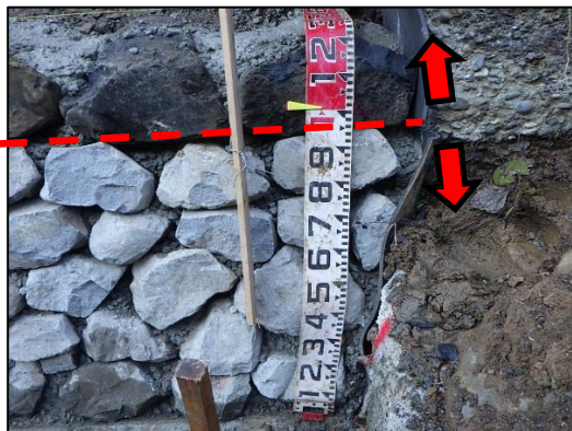
写真3 災害復旧工事と併せて実施した県単工事箇所（白い石材は河床に隠れる範囲で使用）
