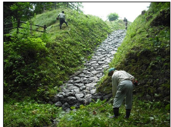
写真3 砂防惣代による維持管理状況
