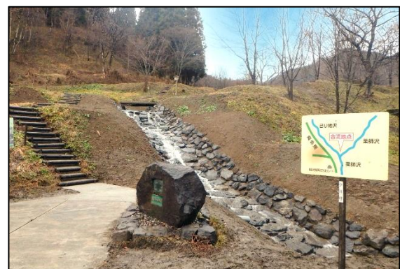
写真4 16号石張水路工（復旧後）
