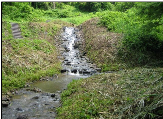
写真1 16号石張水路工（被災前）
