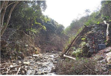
写真-1 崩壊した本谷の砂留
