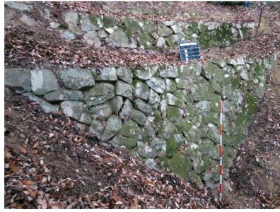
写真-2 2段構造の谷止工
