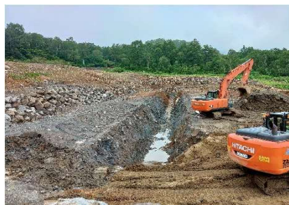
図-3 溝掘り・転石除去状況
