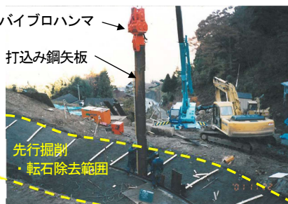
図-4 鋼矢板基礎打込み状況
