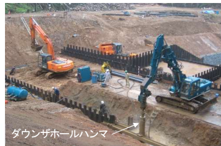
図-5 ダウンザホールハンマ施工状況
