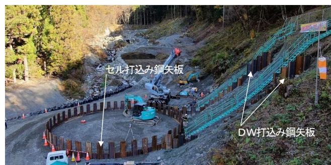
図-2 掘削レス工法の施工中の代表例 (セル+ダブルウォール)
