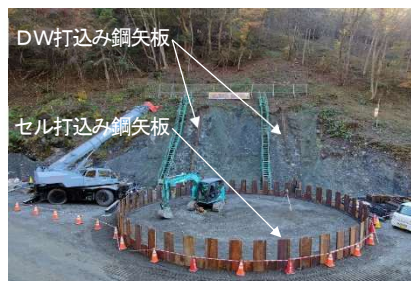
図-7 セルとダブルウォールによる掘削レス事例
