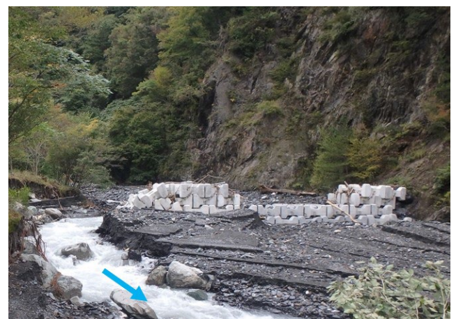
写真5 ブロックの連結事例
