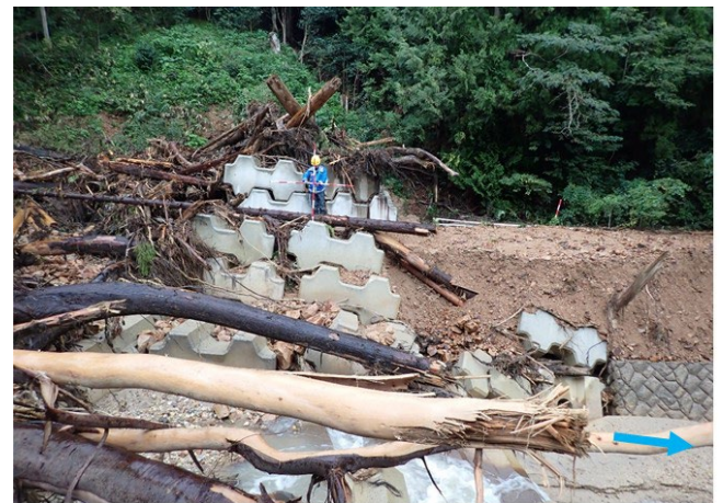
写真4 ブロック流失の事例
