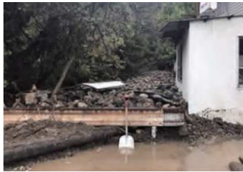
図5 被災状況（上田市茂沢）
