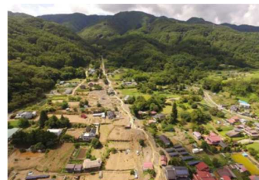
図6 被災状況（茅野市高部）
