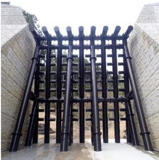
(a) 竣工後 (令和 5 年 3 月)
