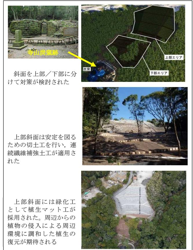
図-4 複合補強土工法による「寺山炭窯跡」での復旧事例<sup>2)</sup>
