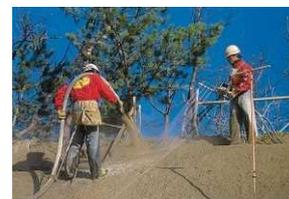
図-2 連続繊維補強土工施工状況
