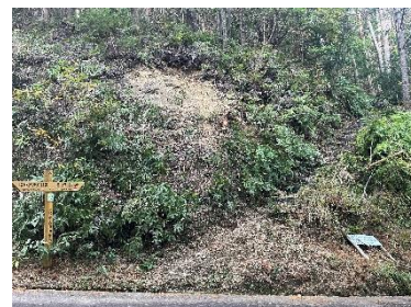
写真1 横垣峠登り口の崩落土砂撤去後(2024.3.12撮影)
