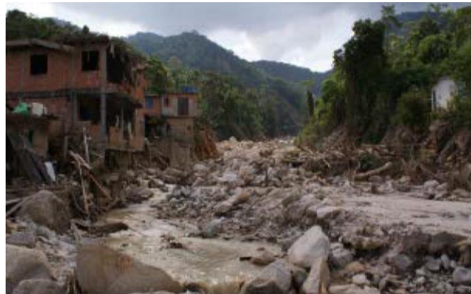
図-1 2011 年豪雨による土石流堆積物の状況 【テレゾポリス市プリンシペ川】(出典：統合地域開発省提供)
