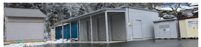
図 6 改変箇所の写真
