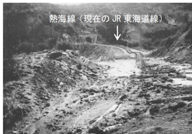
写真2 山津波のため線路埋没せる米神山隧道 東口坑門（鐵道省、1927へ加筆）
