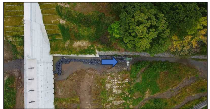
写真-1 チケッペ川砂防堰堤(上)と簡易魚道(下)。
