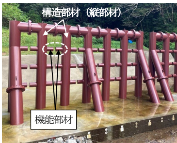
図－1 機能部材の一例（下流視）
