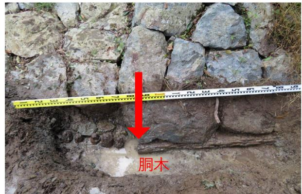
写真-1 左岸側法面の基礎部(上段)の胴木
