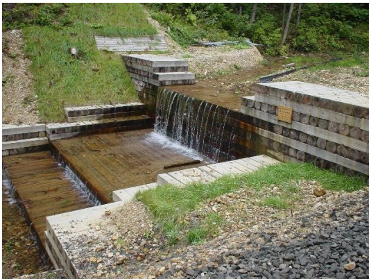
写真1 オールウッド型木製治山ダム
