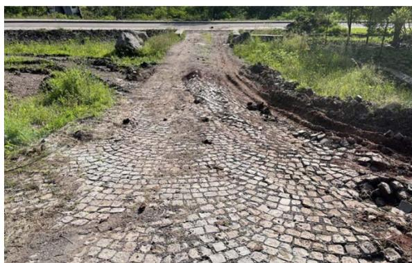
写真1 黒綿土上の道路の損傷状況<sup>1)</sup>
