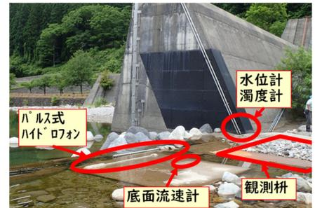
図-2 流砂観測設備の基本構成
