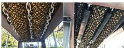
写真-3 礫の捕捉状況及び各部材のたわみ状況
