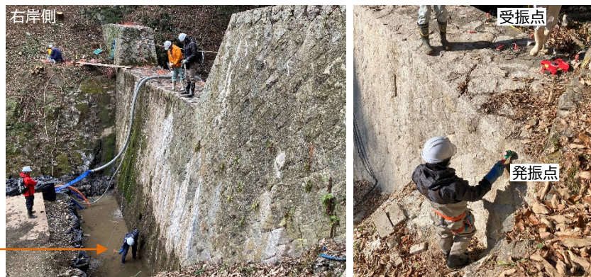
写真-2 改良型弾性波探査の実施状況例
