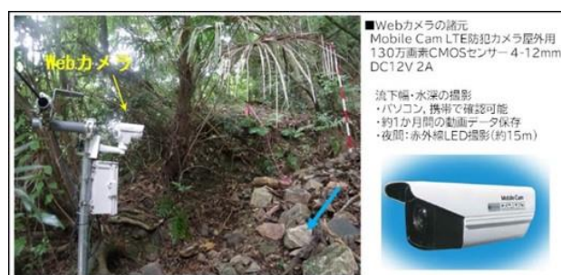
図-2 観測機器の設置状況
