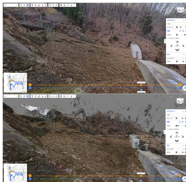
図5 2023/12/26点検時の状況(上写真、下点群)
