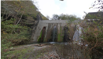
写真 1 城内堰堤の正面写真
