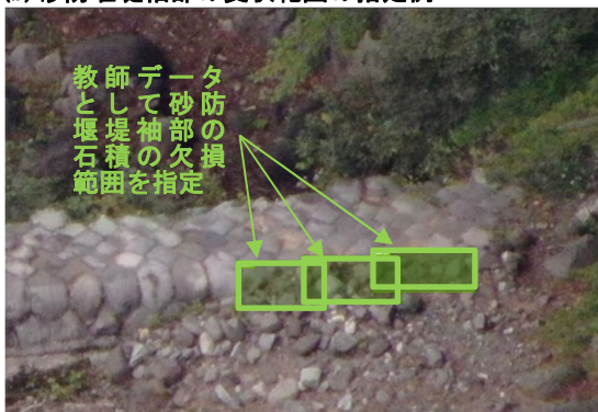
図-2 教師データ作成におけるアノテーションの例(石積/石張の欠損の範囲を矩形で設定(緑の範囲))
