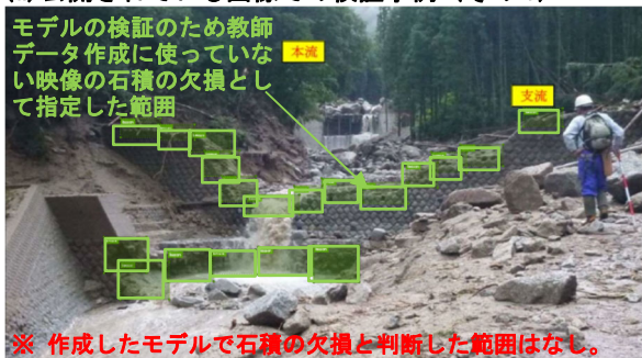
図-3 オリジナルデータでの検証結果の例（緑色は学習用データで欠損箇所として設定した範囲，赤は構築したモデルで欠損箇所として抽出した範囲，両者はほぼ同じである。）
