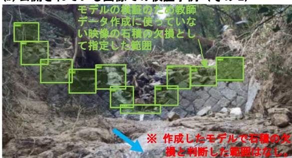
図-4 公開されているデータでの検証事例（緑は石積/石張りの欠損としてアノテーションしているところ，赤囲みは判定，結果的に過学習の影響で全く判定できていない）
