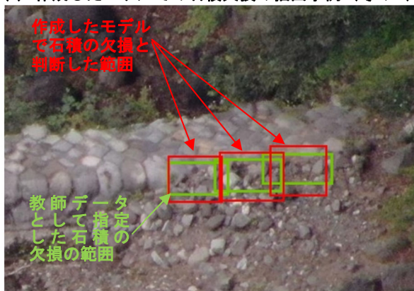
図-3 オリジナルデータでの検証結果の例（緑色は学習用データで欠損箇所として設定した範囲，赤は構築したモデルで欠損箇所として抽出した範囲，両者はほぼ同じである。）
