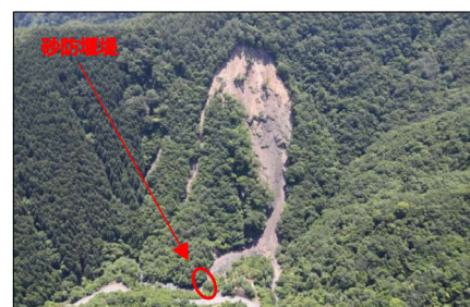
図 3 詳細調査必要箇所事例 （高野町相の浦）
